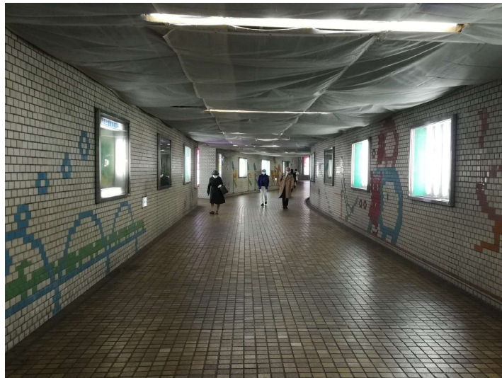
<工事着手前 壁面状況>
