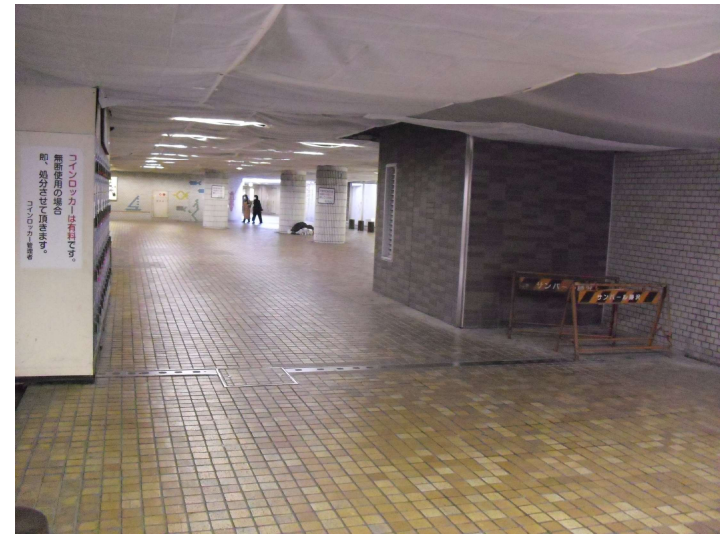
<工事着手前 タイル舗装状況>
