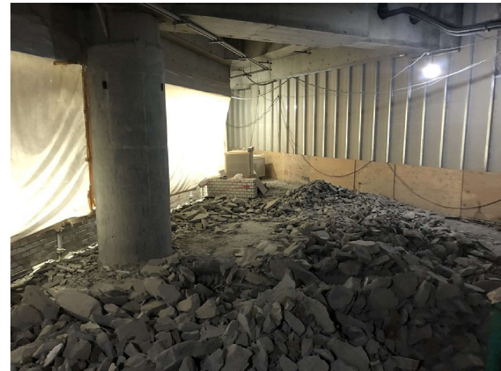
<タイル舗装の撤去状況>
