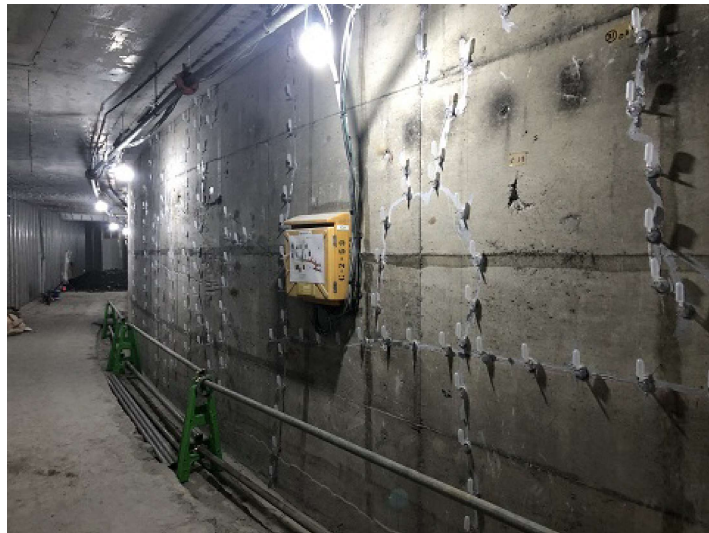
<躯体のひび割れ補修状況>
