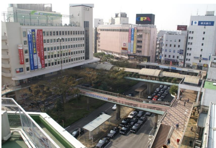
■藤沢駅南口駅前広場の様子
