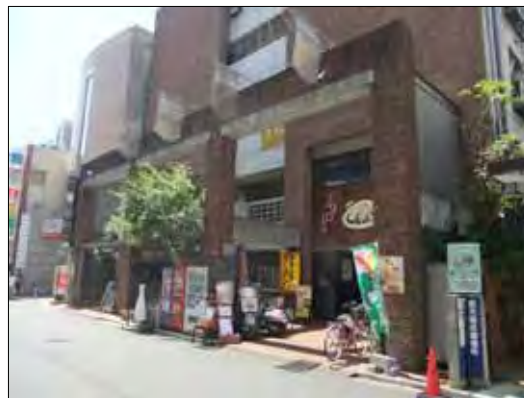
駅付近の商業テナントビル
