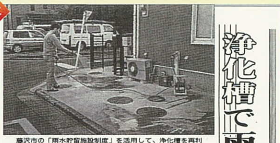
藤沢市の「雨水貯留施設制度」を活用して、浄化槽を再利用し散水 — 同市亀井野
