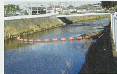
河川除塵機(引地川) 平成20年度は境川・引地川合計で、5.09トンのごみを収集しました。
