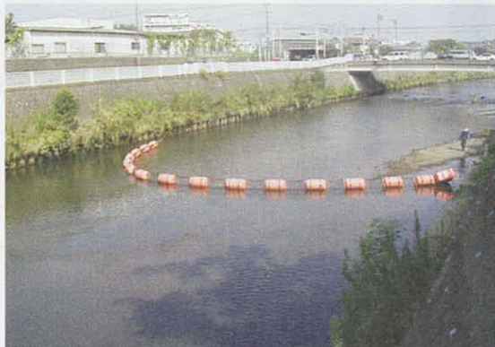
河川除塵機(引地川)
