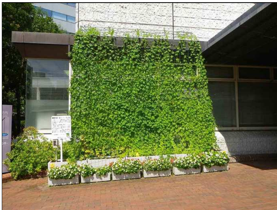
【市役所新館入口付近の建物緑化の様子(緑のカーテン)】
