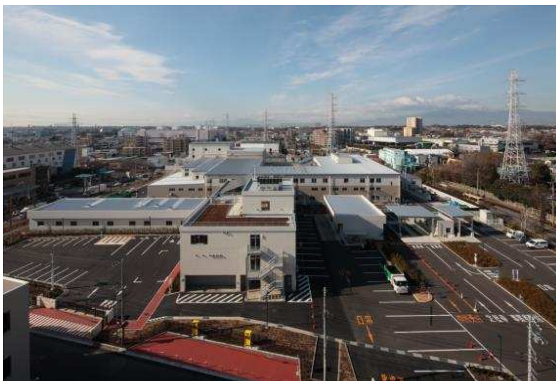
【リサイクルプラザ藤沢（全体）】
