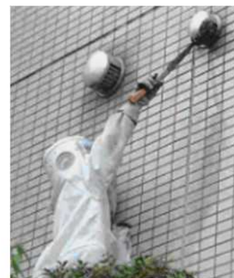
【スズメバチの巣の撤去風景】
