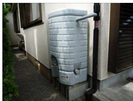
【雨水貯留槽設置例】
