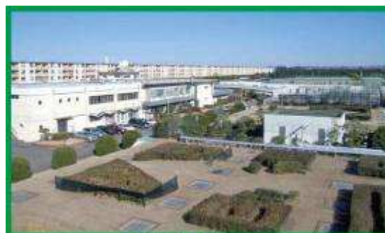
【辻堂浄化センター】
