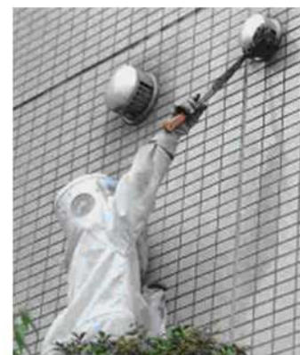
【スズメバチの巣の撤去風景】
