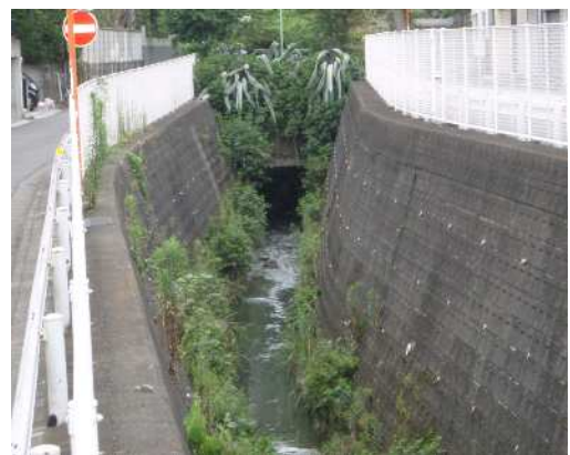
(3) 一色川1号橋上流 (河川指定区間上流部)
