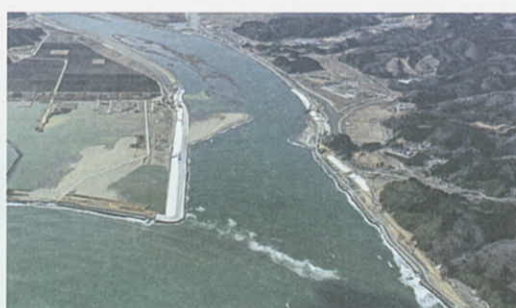
2月25日 北上川河口部の堤防完成(石巻市) 国土交通省東北地方整備局北上川下流河川事務所撮影
