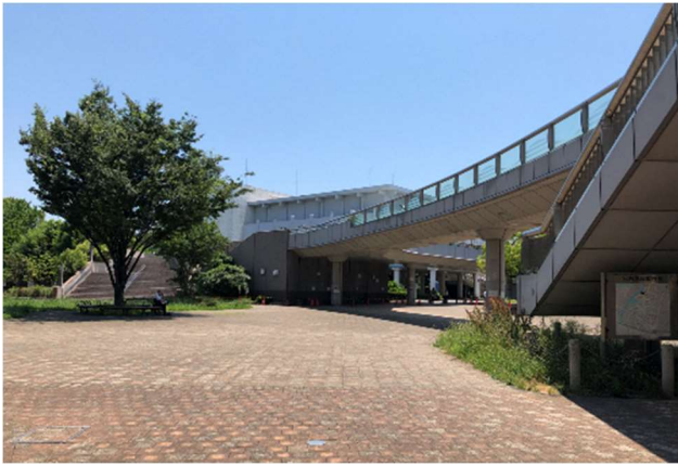
①ペDESTリアンデッキ (事業対象地北西角から望む)
