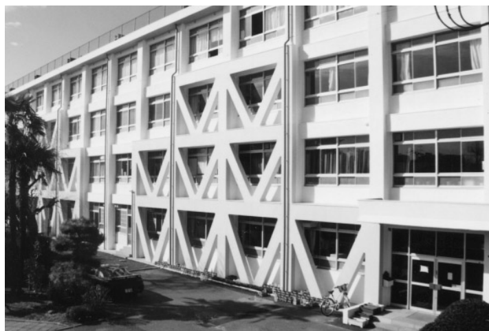
耐震補強された校舎（湘南台小学校）
