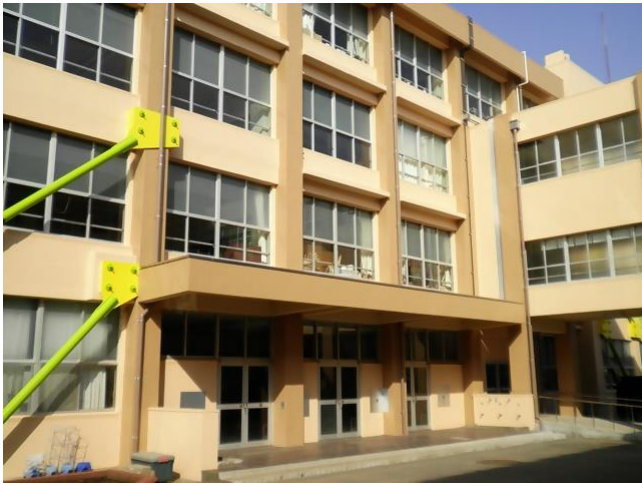
1 大庭小学校外壁等改修工事
