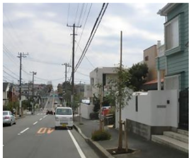
6 片瀬山団地幹線街路樹更新工事
