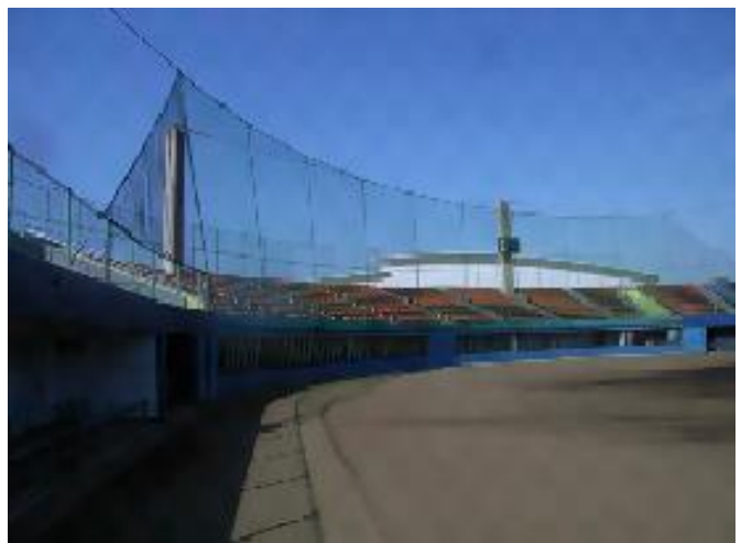
4 八部公園野球場改修工事
