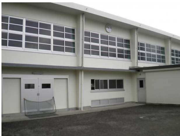
3 御所見中学校体育館外壁改修工事
