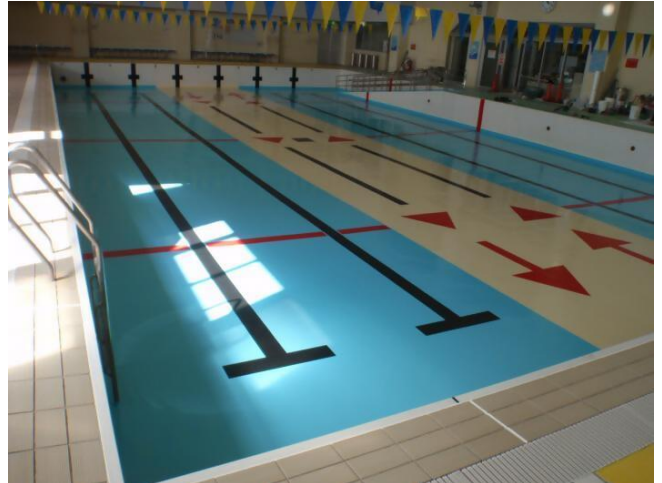
2 石名坂温水プール改修工事
