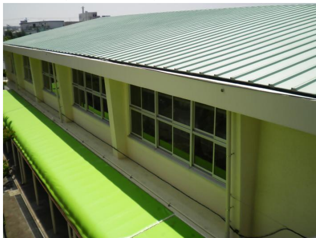
2 鶴沼小学校体育館外壁等改修工事
