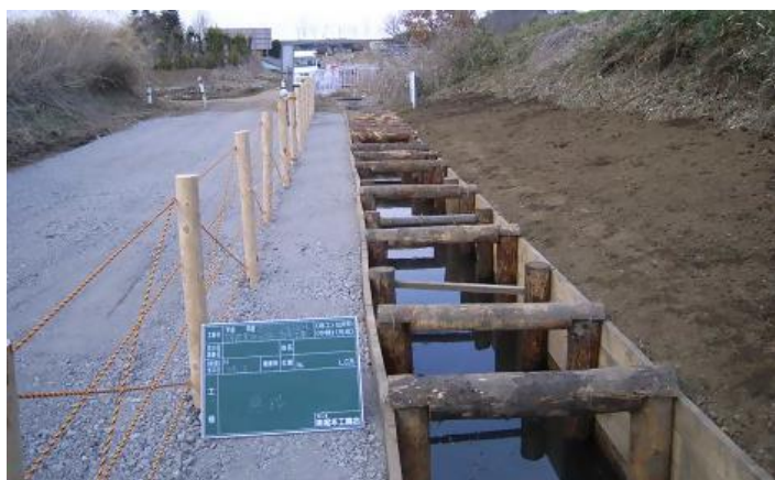
5 宮原地区目久尻川左岸農業用水路改修工事
