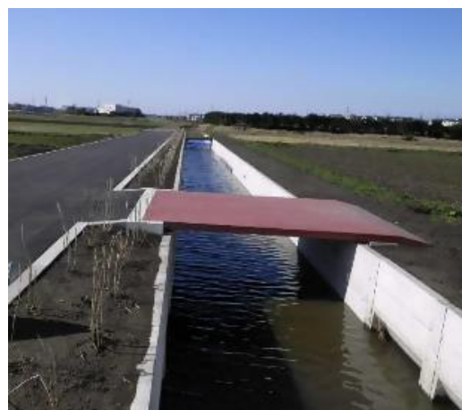
4 宮原地区目久尻川右岸農業用道水路改修工事
