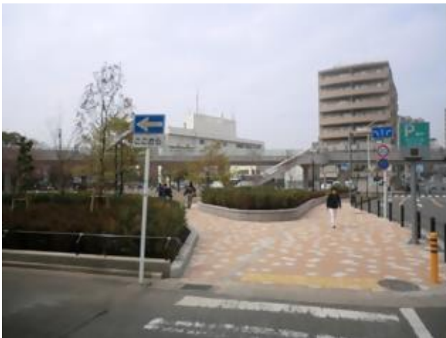
3 奥田公園多目的広場新設工事
