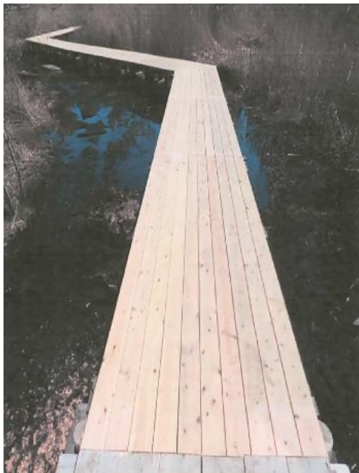
1 引地川親水公園遊歩道改修工事
