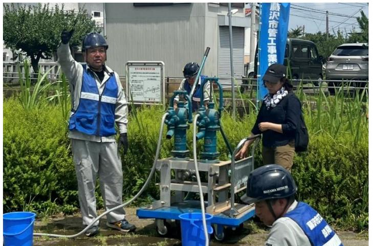
天神公園の地中には、100tの耐震性水槽（以下、100t水槽）が埋められており、給水に必要な機材は公園内の防災倉庫に格納されています。この水槽は平常時、水道の配管の一部になっている為、常に新しい水が流れています。
