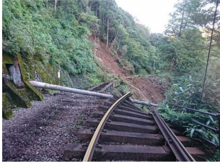
■ 2019(令和元)年台風第19号による箱根登山鉄道の被災状況
