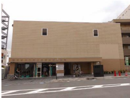
【藤沢駅北口第2自転車等駐車場】
