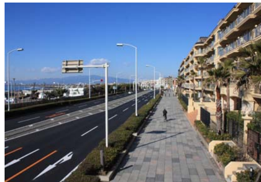
国道134号（中央部）
