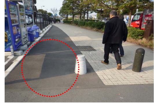
アスファルトに復旧された舗装
