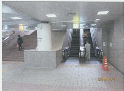
地下道出入口でのエスカレーター設置によるバリアフリーのイメージ (湘南台駅地下道)
